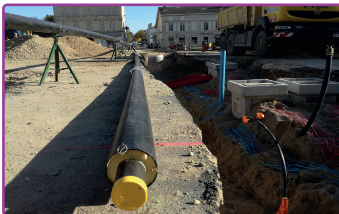
Installation du réseau de chaleur à Aiguillon
